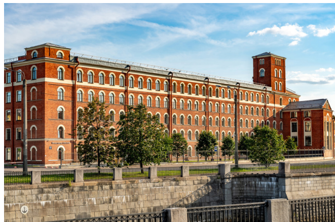
Наб. Обводного канала, д. 60
